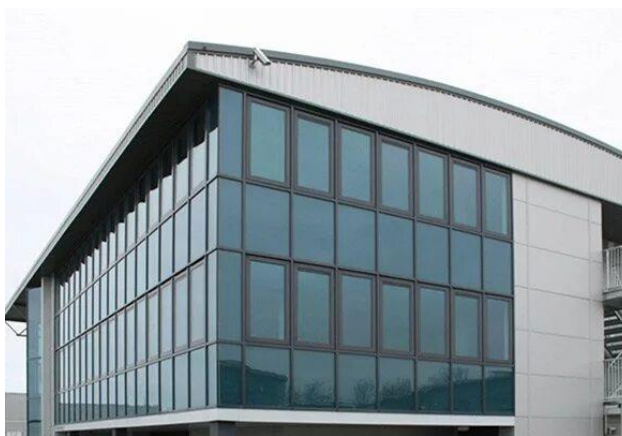
Рис. 1. Вид современных оконных конструкций в промышленных предприятиях
