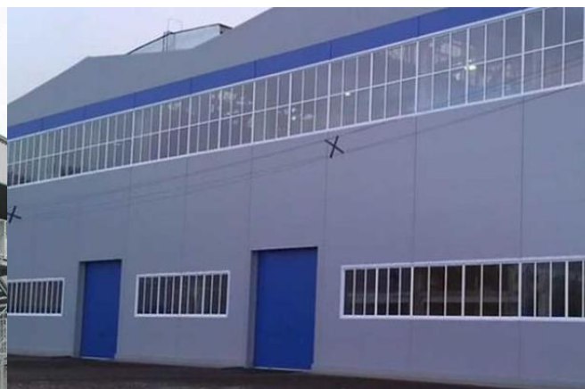
Рис. 2. Вид современных оконных конструкций в промышленных предприятиях
