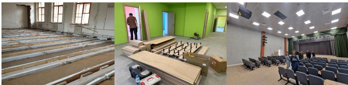
Рис. 4. Установка необходимого оборудования в зданиях
