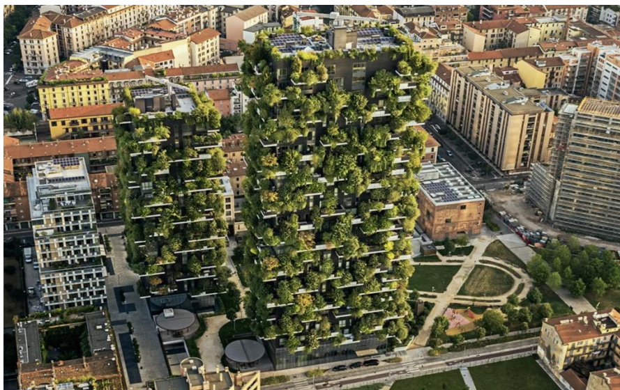
Рис. 1. «Зелёный» фасад зданий Bosco Verticale в Милане (Италия)
