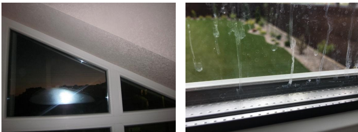
Рис. 5. «Морозные удары» при разгерметизации секлопакета и высохшие капли при разгерметизации стеклопакета
